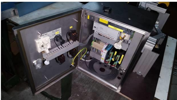
Fig. 18. Tabloul electric al robotului
